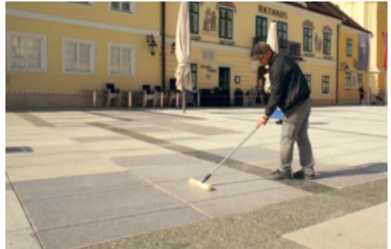
Die Platten werden mit einem Porenfüller behandelt, bevor die Heiß-Imprägnierung erfolgt
