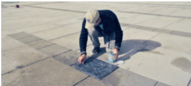
Ein spezieller Fett- und Wachsentsferner wird aufgetragen
